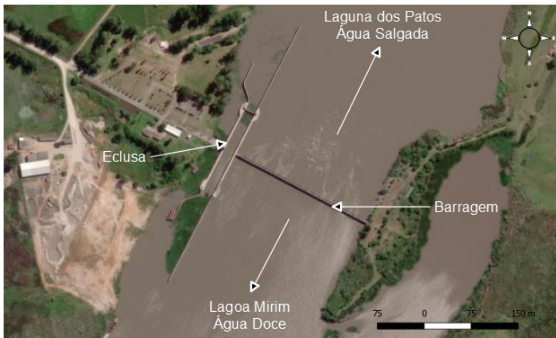
Figura 4 - Localização da eclusa e barragem no Canal São Gonçalo. Fonte: Próprio autor.
