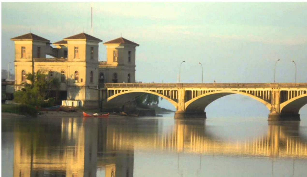
Ponte Internacional Barão de Mauá - Jaguarão
