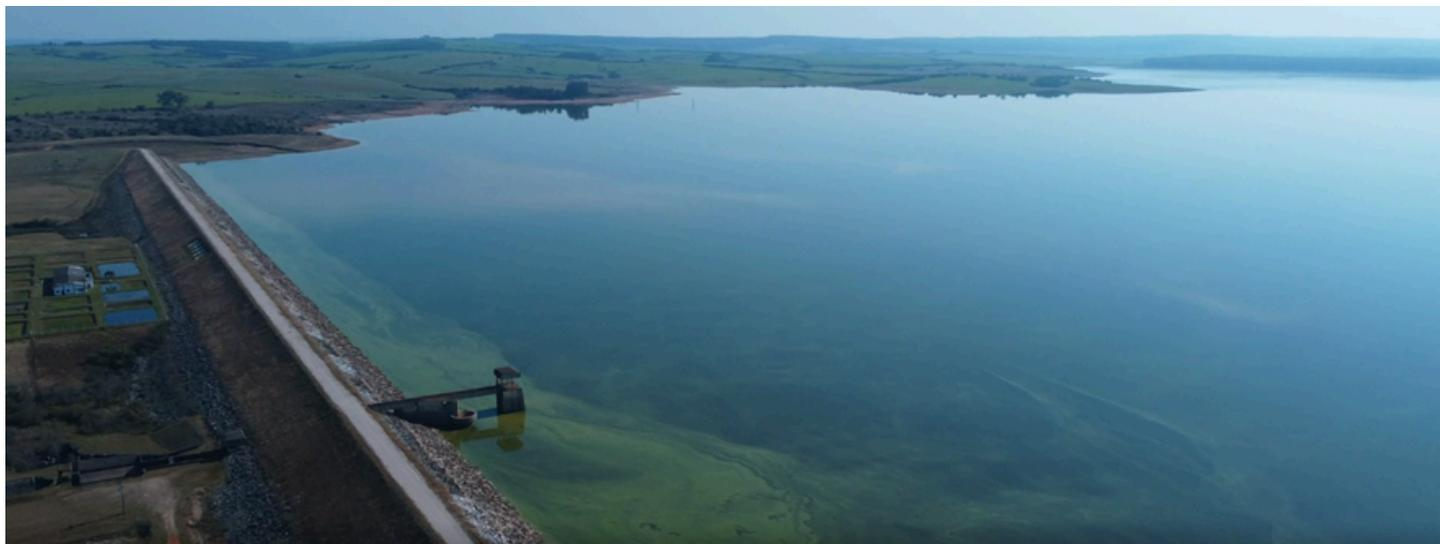
A Barragem do Arroio Chasqueiro, localizada a 3 km da BR-116, no município de Arroio Grande-RS, é uma barragem de terra, com 1200 metros de comprimento e máxima altura de 22 metros, em operação desde 1983. Sua área de alagamento está próxima a 1.650 hectares e armazena um total de 117 milhões de metros cúbicos de água, sendo assim garantindo a disponibilidade hídrica e garante a produção agrícola, evitando perdas de safra consequentes das frequentes estiagens de primavera-verão.
