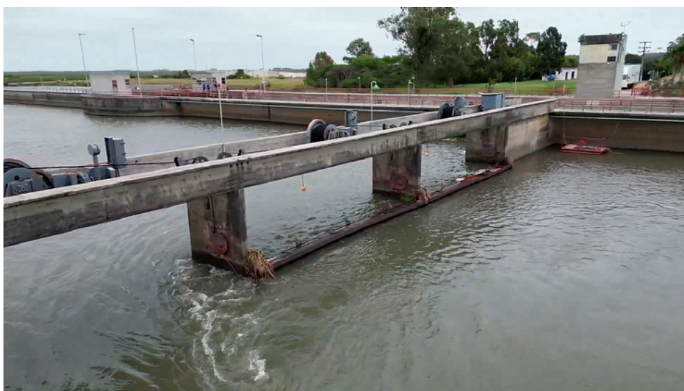
Figura 3: Foto em detalhe da cota de topo das comportas da barragem.
