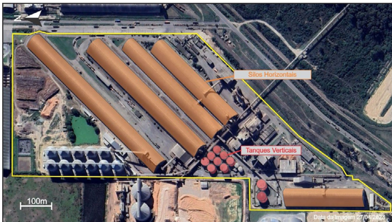
Figura 13: Silos e tanques do Terbian.
