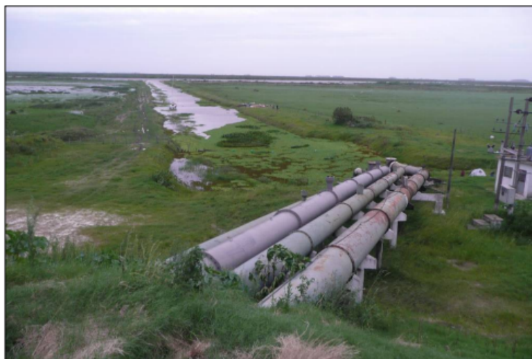
Figura 102: Área de banhado na região de implantação do Terminal do Rio Tacuari.
