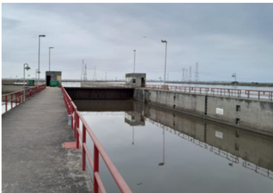
Figura 8: Foto do interior da câmara de eclusagem e guarda-corpos.
