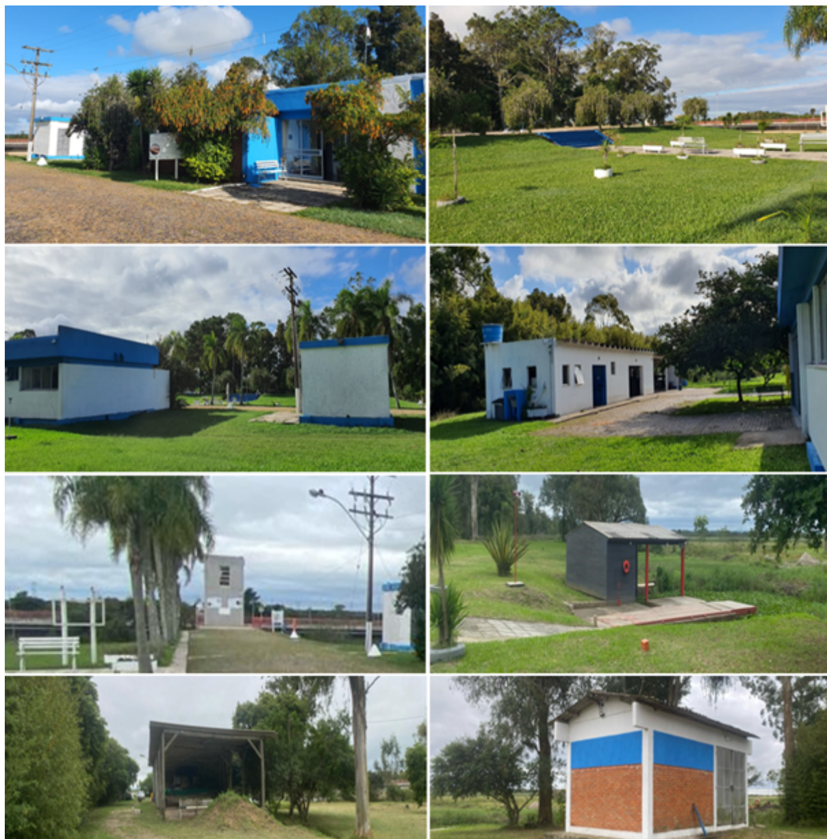
Figura 25: Ilustração do Complexo da Barragem.
