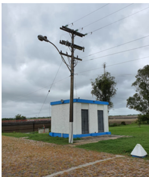
Figura 17: Prédio da Subestação.
