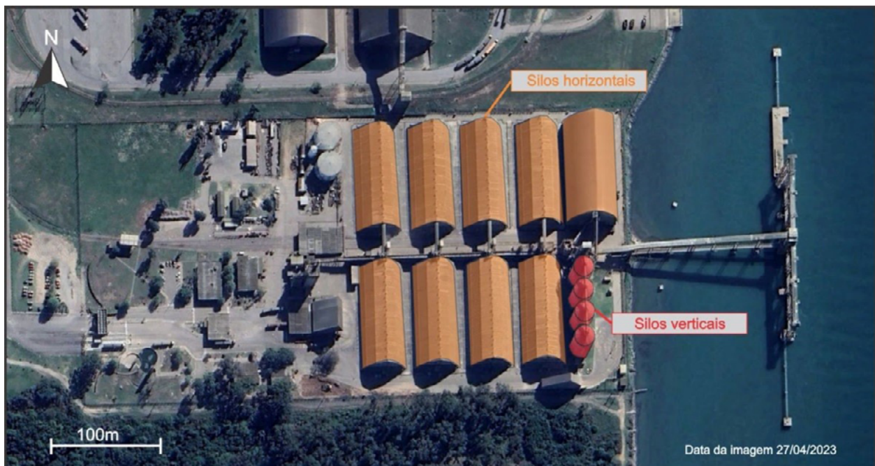
Figura 16: Silos horizontais e verticais do Termasa.
