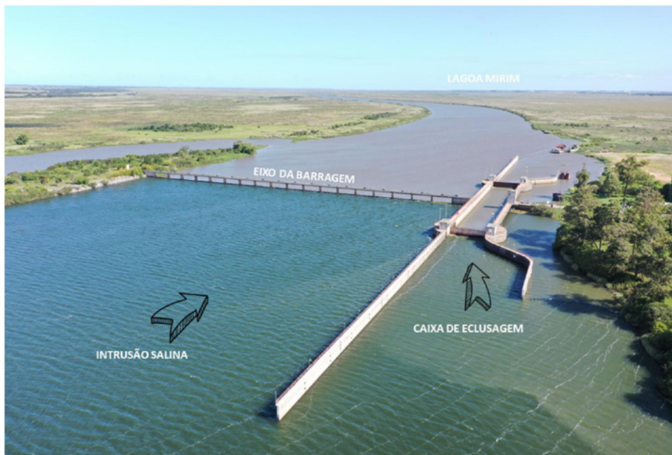
Figura 1- Barragem e Eclusa Canal São Gonçalo
