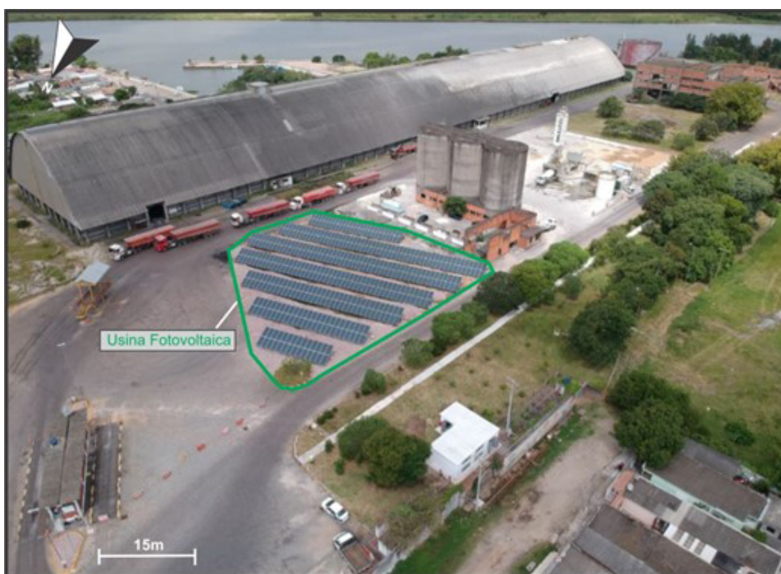
Figura 39: Atualização do sistema de geração e fornecimento de energia elétrica do porto de Pelotas.
