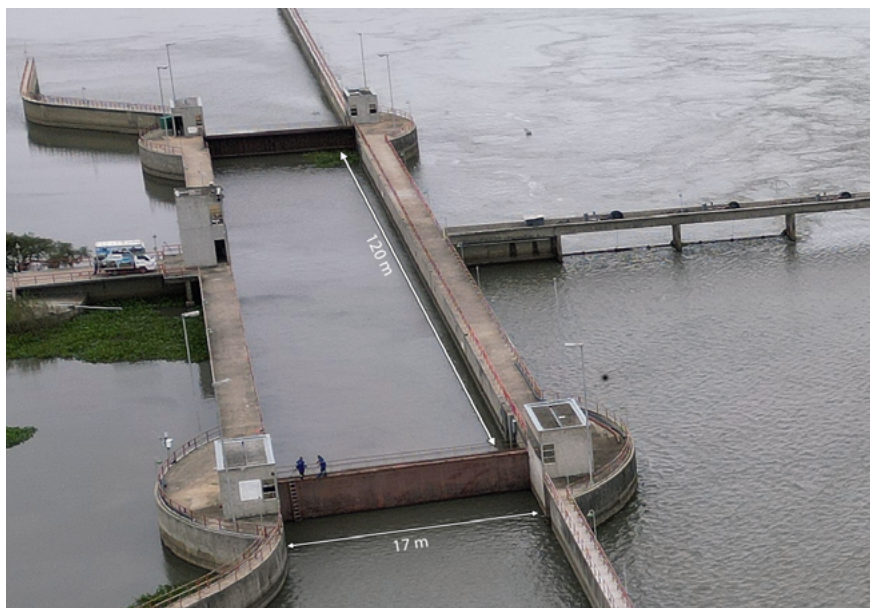
Figura 7: Foto aérea da câmara de eclusagem e suas comportas.
