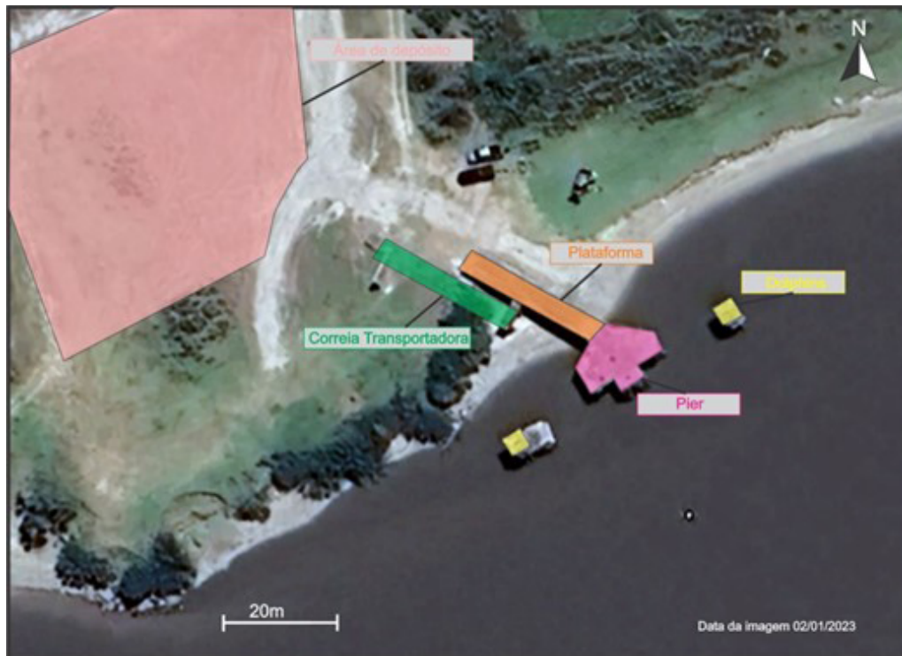
Figura 71: Antiga infraestrutura do Porto de Santa Isabel.
