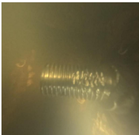
COMPORTA-5 (PINO HORIZONTAL, ROSCA DANIFICADA E SEM PORCA)
