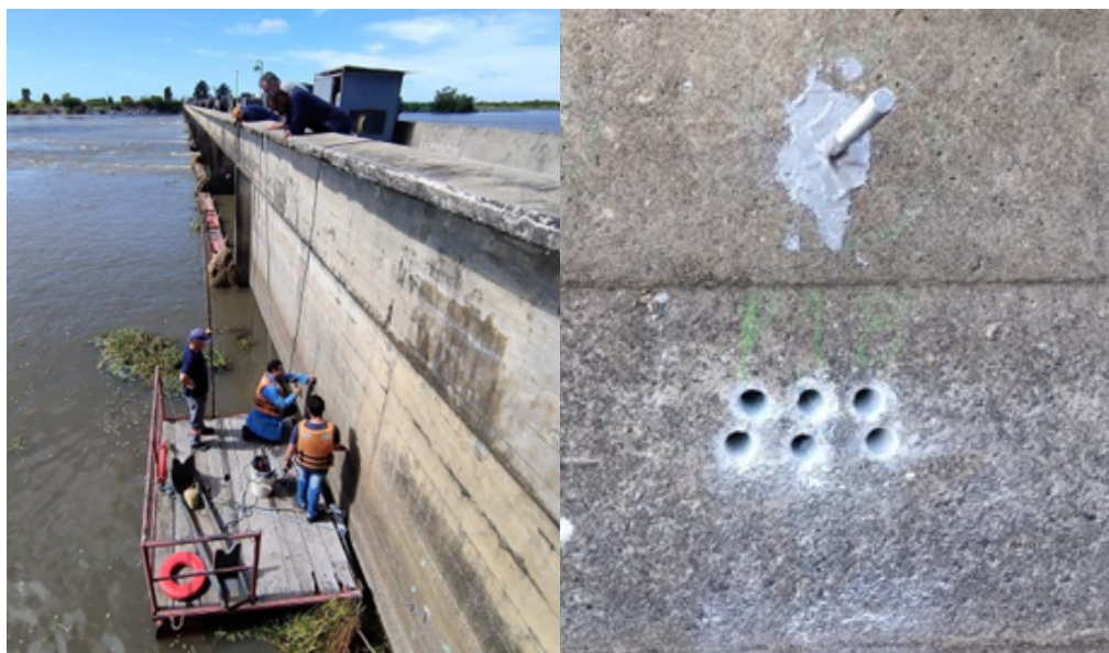
Figura 26: Extração dos testemunhos e amostras de concreto.
