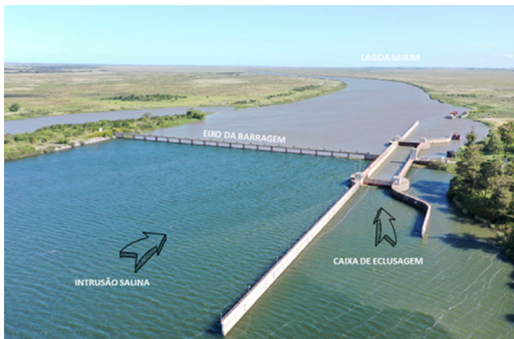
Figura 2: Visão geral da Barragem e Eclusa do São Gonçalo.
