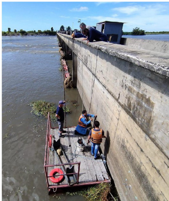
Figura 3 – Extração dos testemunhos e amostras de concreto
