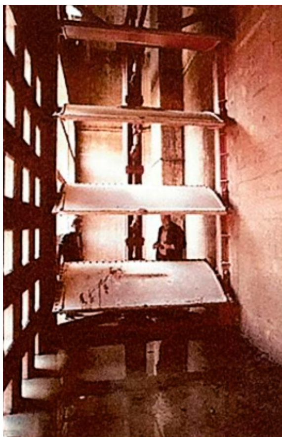
Figura 12: Desenho do sistema de aberturas nos muros da câmara de eclusagem e externo, para o trânsito da água pelas comportas do by-pass.
