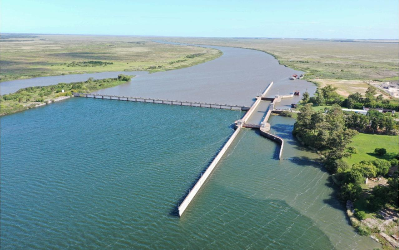
A Barragem do Canal São Gonçalo foi inaugurada em 1977, ela foi construída através do Plano de Desenvolvimento da Bacia da Lagoa Mirim. As estruturas hidráulicas impedem a entrada das águas salinas do Oceano Atlântico na Lagoa Mirim, possibilitando a captação de água a ser utilizada para a irrigação, bem como para o consumo humano nas cidades de Pelotas, Capão do Leão e Rio Grande. Por sua vez, a eclusa possibilita a navegabilidade no Canal São Gonçalo.
